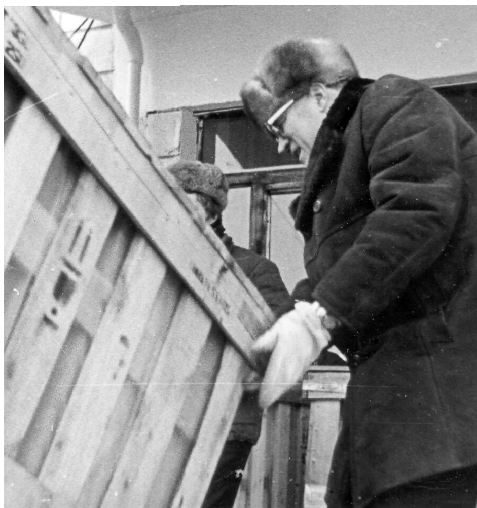
Н.Н.Суслов на строительстве корпуса «Е»
