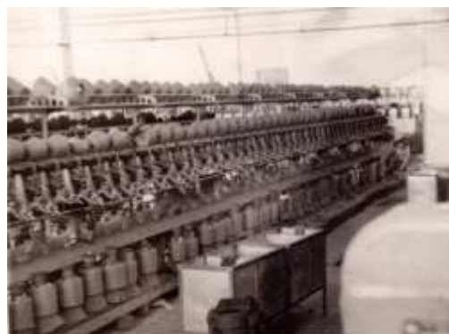
Мотальная машина М-150-1 для перематывания цветной пряжи
