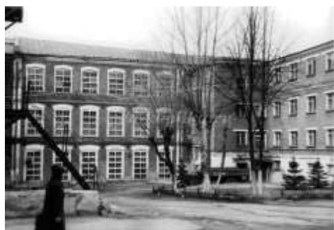
Корпус ткацкой фабрики льнокомбината
